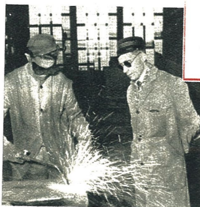
Lasbril met bakelieten oogschelpen en glazen van middelmatige tint. (Werken met de oxy-acetylenische lasbrander — booglassen — metalliseren met de pistoolbrander).
