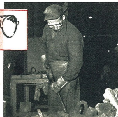
Bril met heldere glazen, metaalachtige montuur, versterkte brilringen en zijschermen uit rasterwerk. (Bedienden belast met beetelwerken, werken in de ketelmakerij, afkappen van oude verfmerken, kappen van brandhout, afbraak en onttaking van wagens en rijtuigen, afbramen van metalen, boren van harde metalen, werken in de smidse, belegging van kussenblokken, slijpen, opkappen van slijpstenen).
