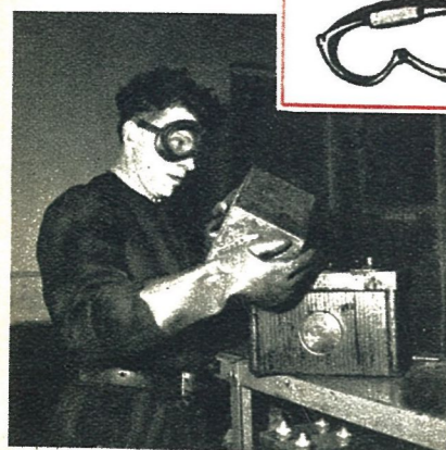
Stofbril bestand tegen zuren. (Werken aan de accumulatoren — behandeling van zuren en andere bijtende producten — behandeling van briketten en as — onkruidverdelging — schoonmaken met perslucht — werken uitgevoerd boven het hoofd).
