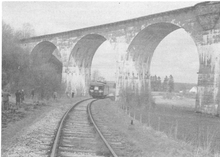
fig. 19 : le viaduc d'Hermanmont (coll. F. Beckers) fig. 20 : le viaduc de Born, sous lequel passe l'autorail affrété par le GTF asbl le 8/4/1972 (photo R. Marganne)
