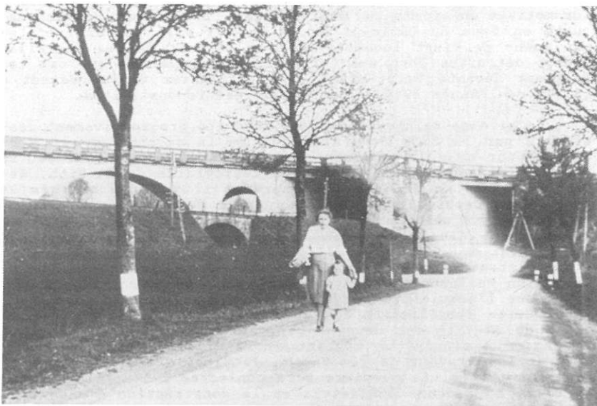
fig. 21 : cette photo "familiale" montre très bien à l'avant-plan la ligne St-Vith - Lommersweiler et au dessus d'elle le saut-de-mouton de la ligne St-Vith - Gouvy (Wiesenbach vers 1940). (coll. H. Gombert)
