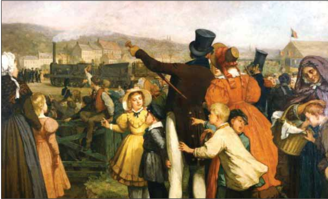
Inauguration de la ligne Bruxelles / Malines, le 5 mai 1835 © SNCB-Holding
