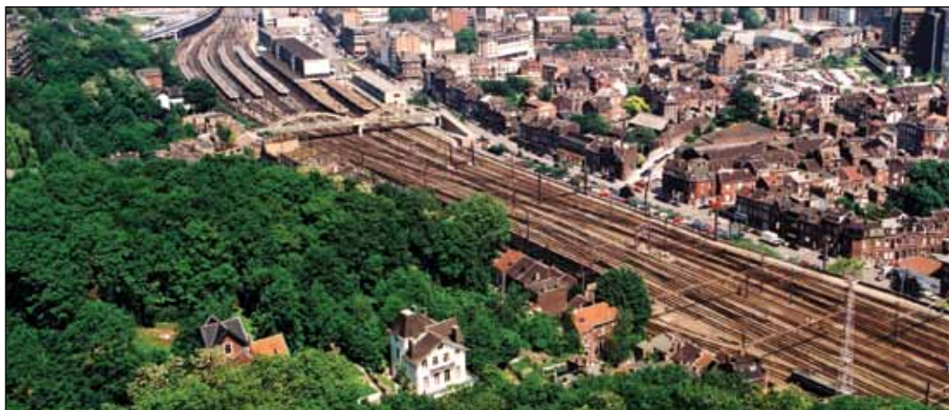
Vue générale du site de la gare des Guillemins avant le début des travaux de la nouvelle gare. © SNCB-Holding.
