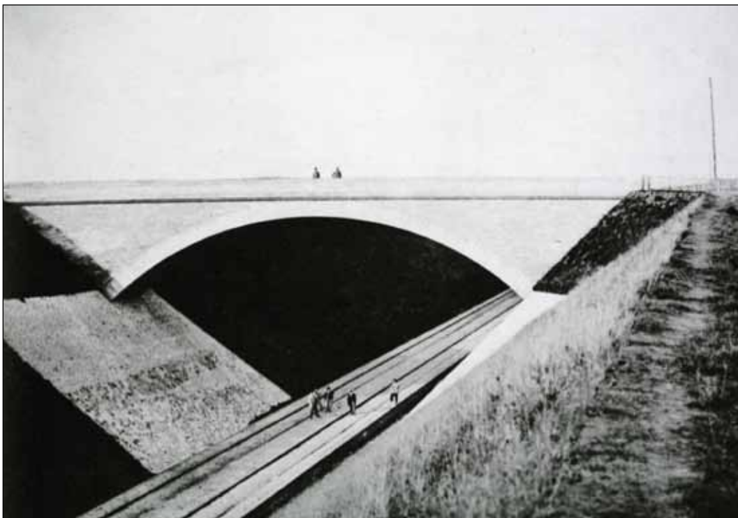
Édouard Baldus, Pont du passage supérieur de l'avenue des Peupliers , sd, photographie, © Coll. Archives nationales françaises.
