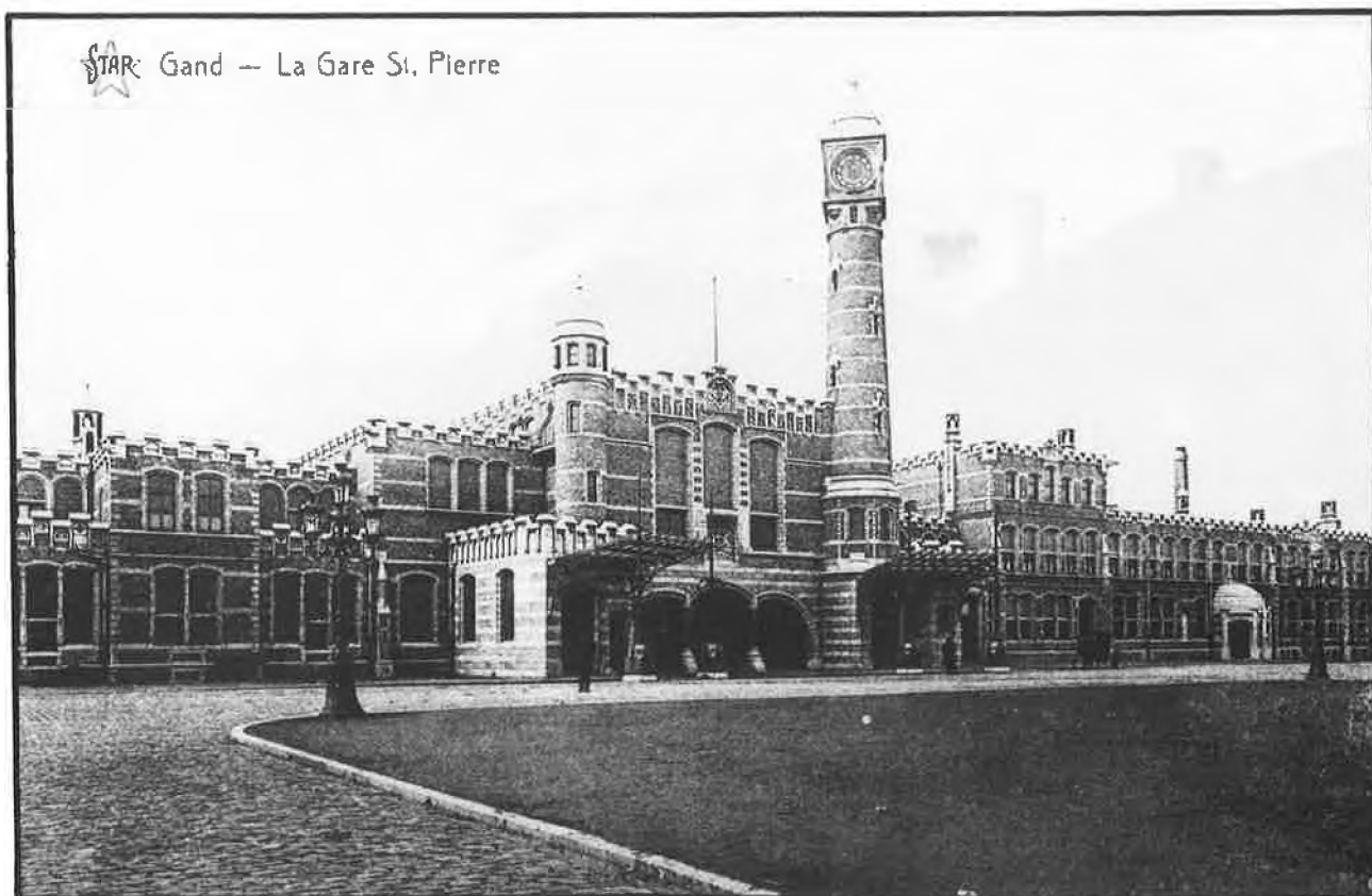
Met het oog op de wereldtentoonstelling van 1913 werd verderop de lijn Brussel-Oostende aan de Voskesweg een prestigieus eclecticismisch gebouw n.o.v. ingenieur-architect Cloquet opgetrokken
