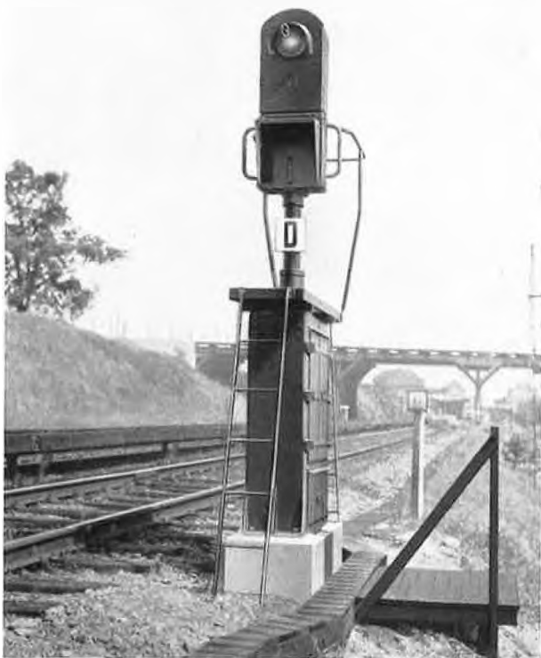
Fig. 12. Signal-relais à lumière du jour, sur une ligne du Chemin de Fer surélevé de Hambourg.
