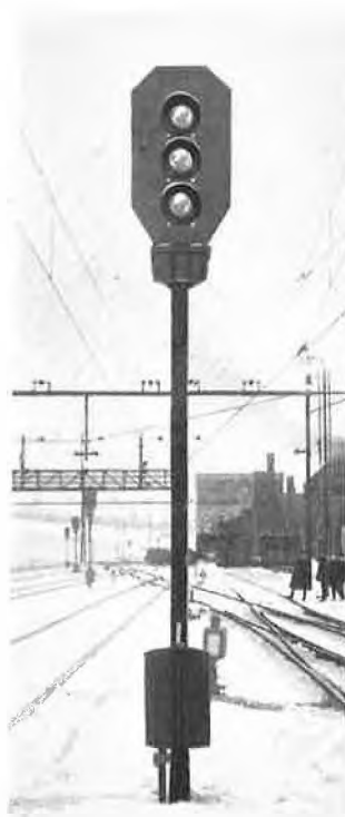
Fig. 19. Signal principal avec lentilles massives. (Coffret d'appareillage fixe au mât du signal.)
