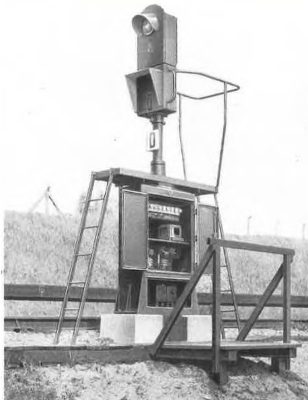
Fig. 21. Signal lumineux de jour du Chemin de Fer surélevé de Hambourg. (Pieds du mât formant armoire pour l'appareillage.)
