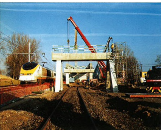
Construction d'un viaduc pour le TGV entre Hal et Bruxelles
