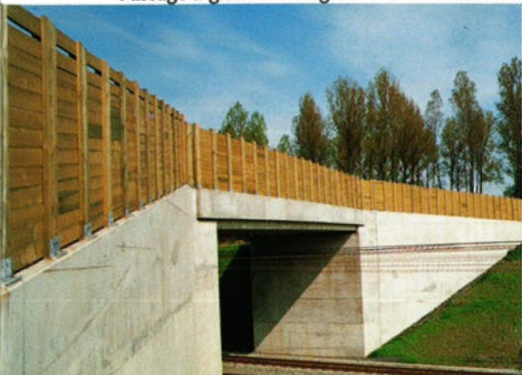
Passage à gibier aménagé au-dessus de la LGV
