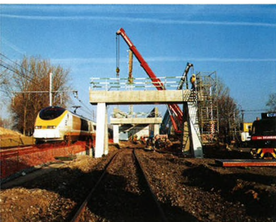
Bouw van een HST-viaduct tussen Halle en Brussel
