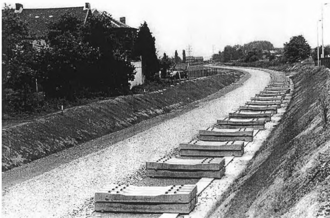
La plate forme est prête, le ballast posé et dans quelques heures les traverses seront en place pour recevoir les rails.
