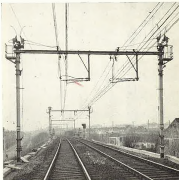
Fig. 14. — Ligne caténaire sur portique : sectionnement à lame d'air.
