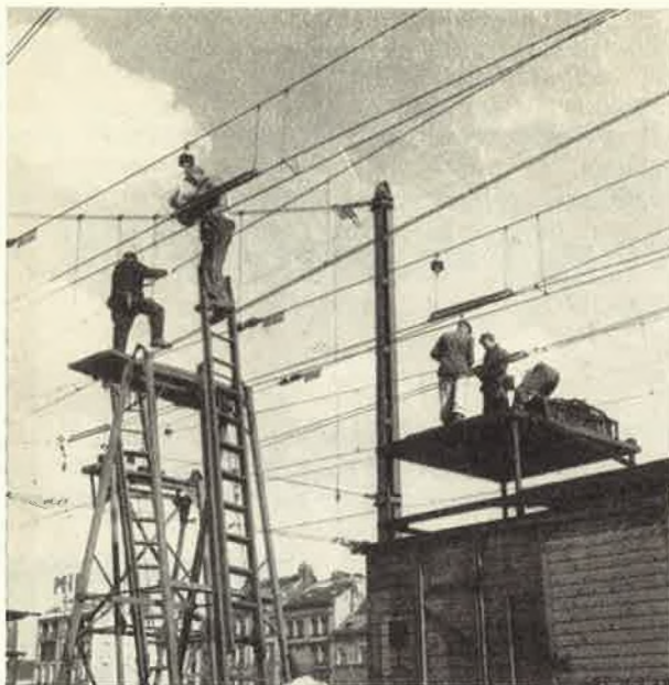
Fig. 24. — Placement d'isolateurs de section.
