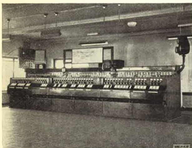
Fig. 13. — Pupitre de commande à leviers individuels.
