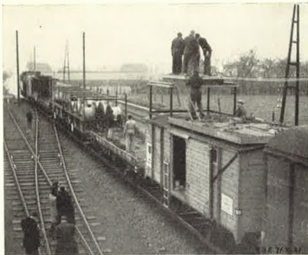
Fig. 21. — Déroulage des fils et câbles.
