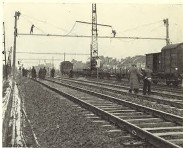
Fig. 19. — Levage d'un portique (6 voies).
