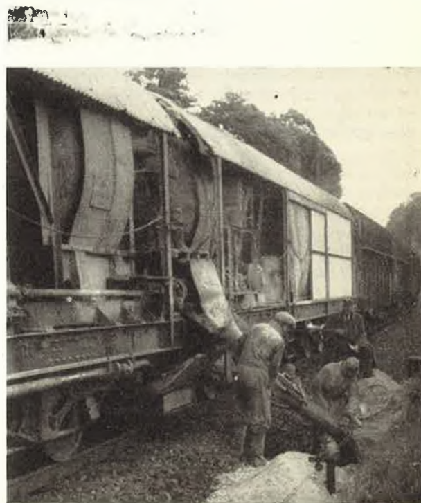
Fig. 17. — Train bétonneur : exécution d'une fondation.
