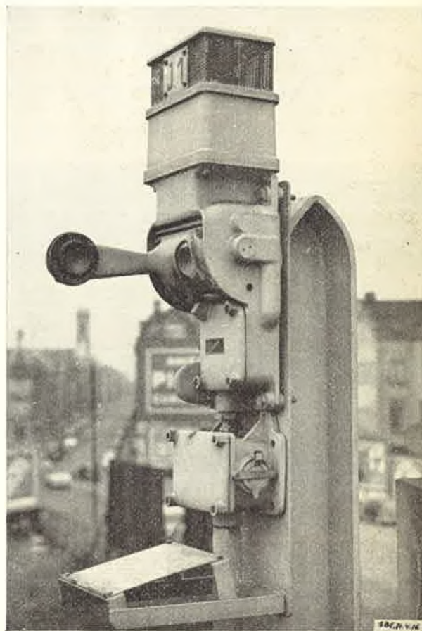
Fig. 16. — Poste téléphonique d'alarme en position de travail.
