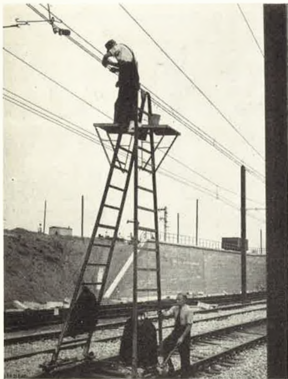
Fig. 22. — Pendulage de la caténaire.
