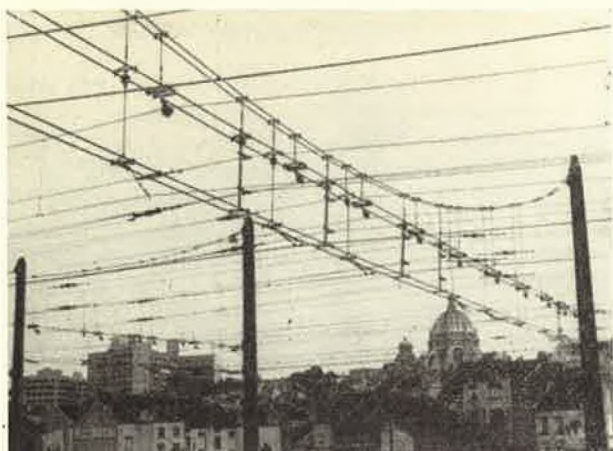
Fig. 27. — Bruxelles-Nord : grand portique souple.
