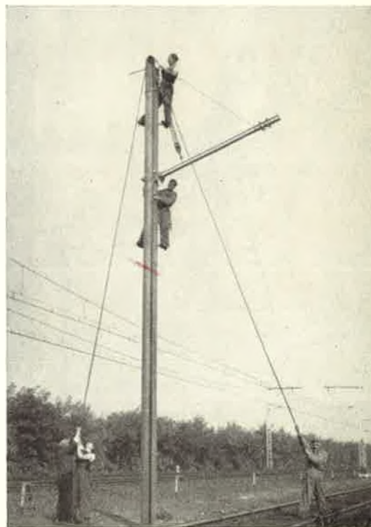
Fig. 20. — Levage à main d'une console (1 voie).
