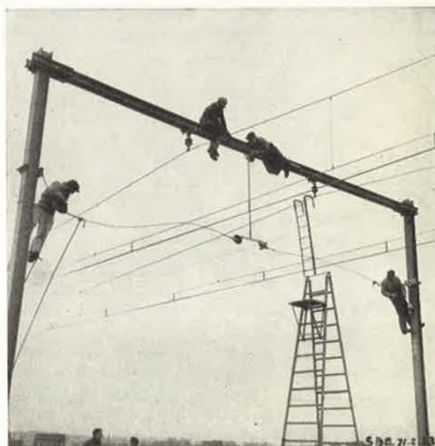
Fig. 23. — Fixation du câble transversal.
