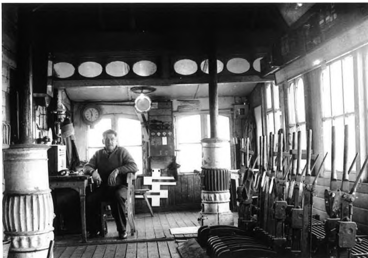
Signaleur en poste à Kinkempois dans une cabine en bois ( technologie Saxby ). Le local est encore chauffé avec des poêles en fonte.
