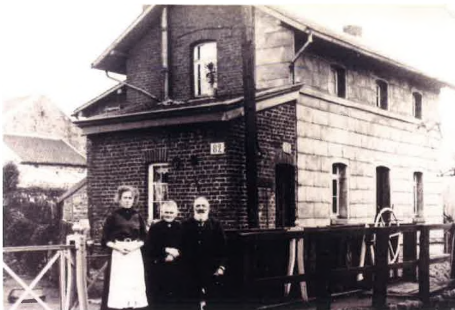
Passage à niveau sur la ligne 39 Herbesthal – Aachen-West avant 1914 : devant la maisonnette de service, la garde-barrière pose avec sa famille ; à droite, la manivelle de manœuvre des barrières.
