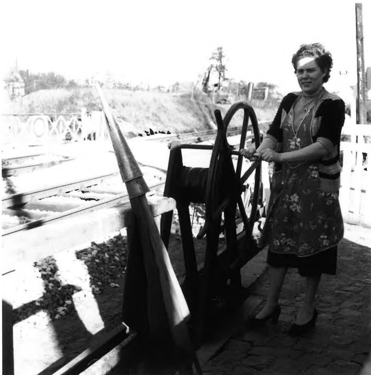
La garde-barrière à son poste, devant la manivelle de manœuvre des barrières roulantes, ici en position « fermées ». Devant elle, l'équipement réglementaire : drapeaux vert, jaune, rouge et cornet acoustique (années 50)
