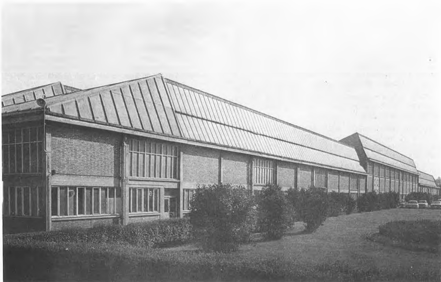
Foto 3 : Een der centrale magazijnen van de Centrale Werkplaats Mechelen.
