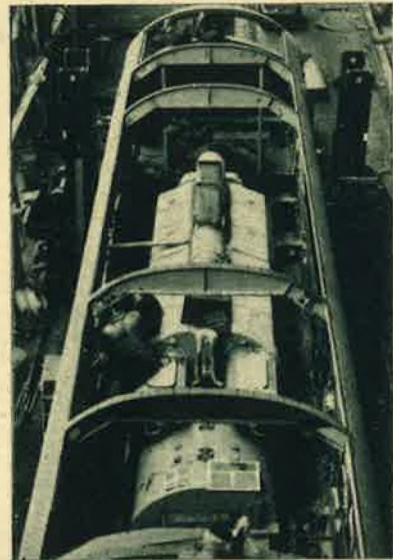
De machinekamer van de locomotief type 202.
