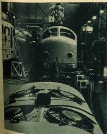
Vooran, de ventilators voor het afkoelingswater van de diesel.
