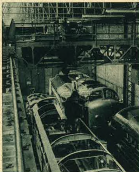
Het neerlaten van de diesel-generatorgroep in de locomotief type 202.
