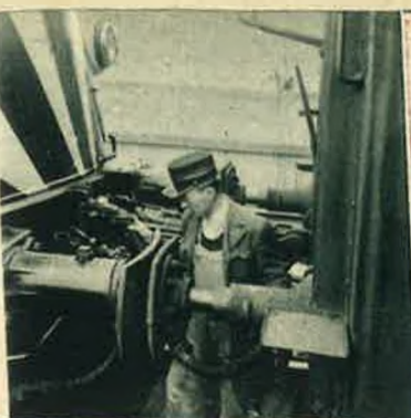
De locomotief komt voorzichtig tegen het stel. De schouwer koppelt haar aan de rijtuigen. De remproef wordt niet vergeten.
