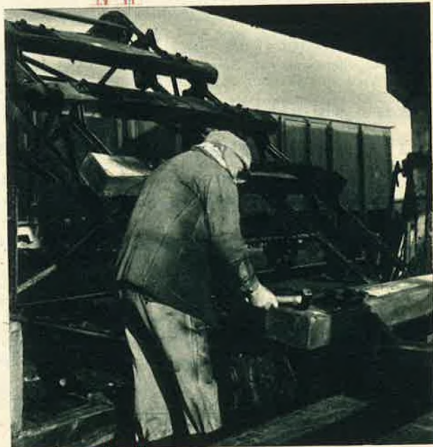
Een ketting zonder einde, voorzien van sleeplaken, voert de dwarsliggers tot in de wagens.
