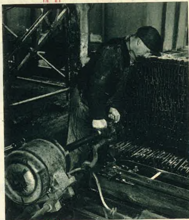
Het bevestigen der onderlegplaten op de dwarsliggers.
