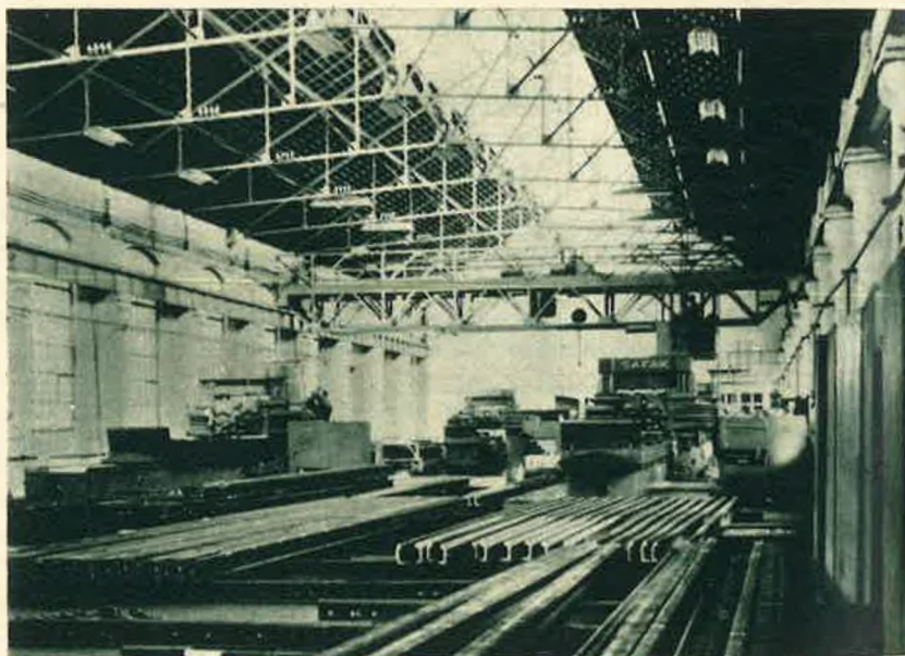
EEN ALGEMEEN ZICHT OP DE SCHAAFMACHINES
