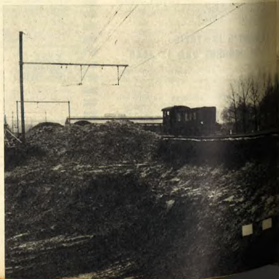
ONDER DE REEDS GESPANNEN RIJDRADEN WORDT EEN AANVANG GEMAAKT MET DE GRONDWERKEN VOOR EEN TUNNEL.
