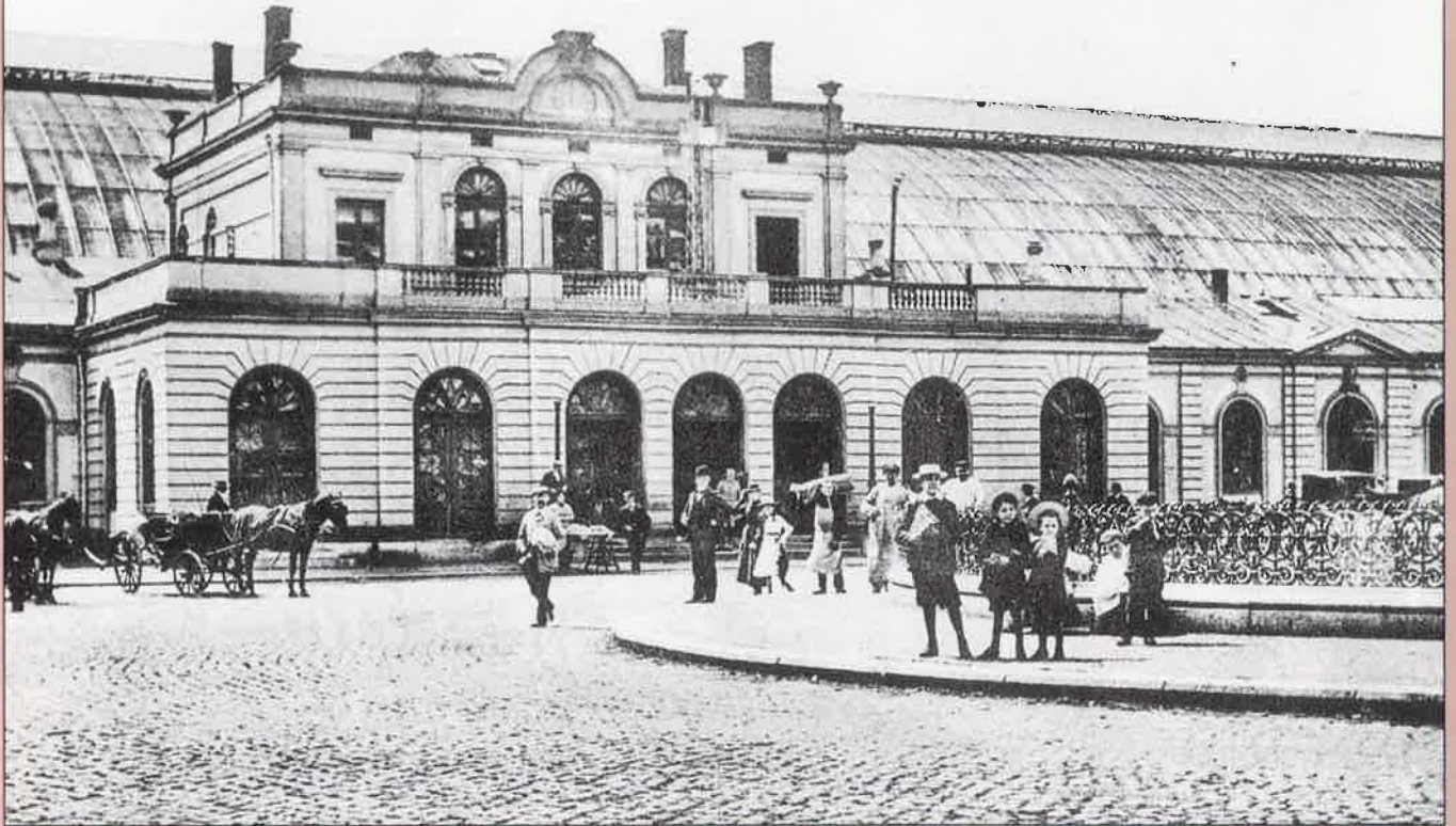
HET EERSTE STATION VAN KORTRIJK, GETEKEND DOOR ARCHITECT AUGUSTE PAYEN. LET OP DE ENORME OVERKOEPELING DIE IN 1878-1879 WERD GEBOUWD. KORTRIJK WAS TOEN EEN BELANGRIJK KNOOPPUNT VOOR HET VERKEER NAAR FRANKRIJK
