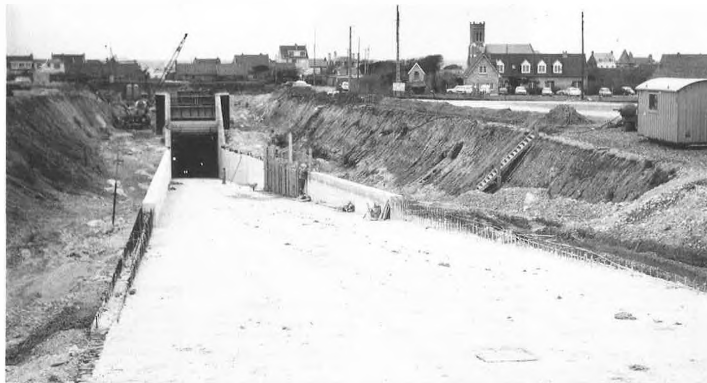
Travaux du tunnel sous la Manche : Sangatte, décembre 1974.
