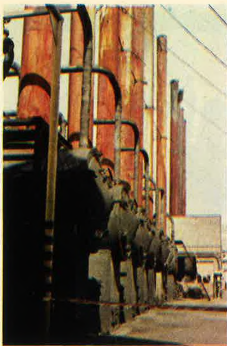
La chaufferie provisoire, constituée d'anciennes machines à vapeur.
