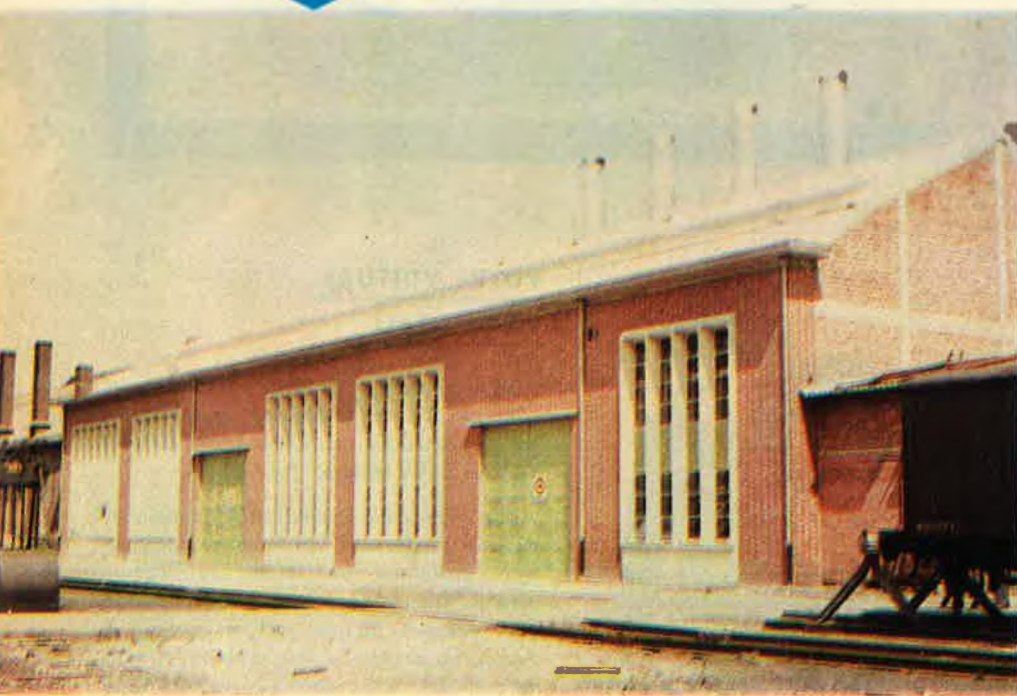
Vue extérieure de la nouvelle chaufferie. Les cheminées individuelles sont calorifugées afin d'éviter le point de rosée et, par là, diminuer la corrosion.
