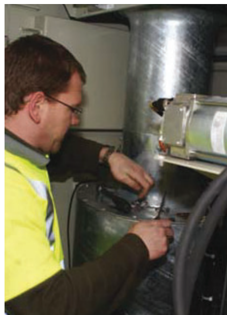
Kris Degrande plaatst een deel van de technische uitrusting
