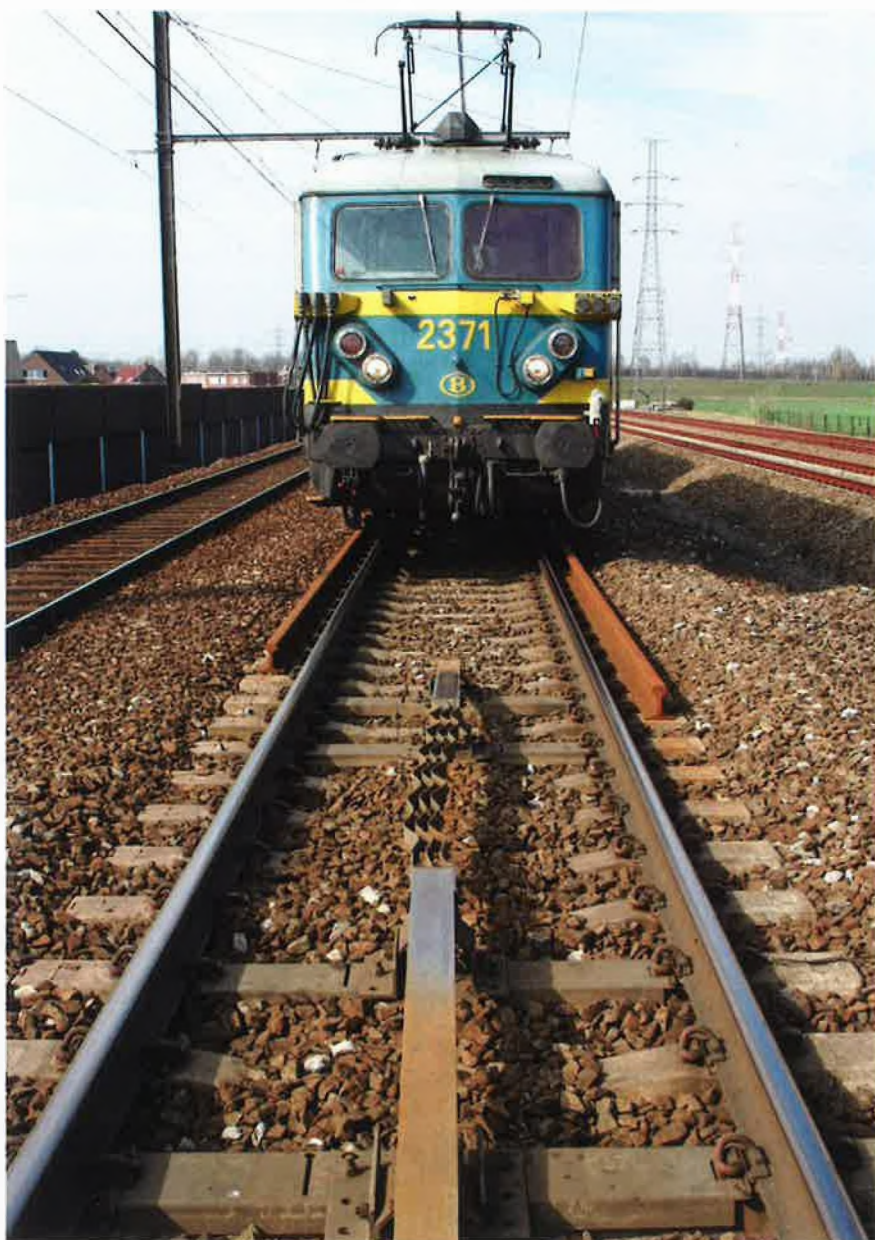
Deze krokodil hoort bij het sein dat op lijn 27A spoor B de vertakking Driehoekstraat in Ekeren beveiligd. De 2371 heeft net Antwerpen-Noord verlaten en de bestuurder is voor het rode sein gestopt. Hoewel de krokodil een dreun moest verwerken, werkt ze nog. Foto: Hans Joosen
