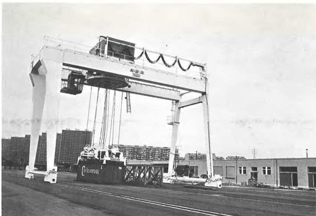
Nieuwe portaalkraan van de container-terminal te Bressoux.
