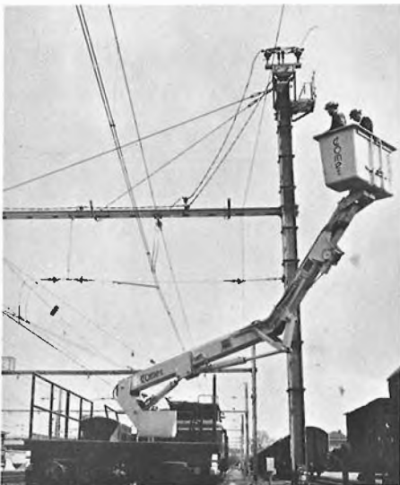
Nieuwe werklift voor het onderhoud van de bovenleidingen.
