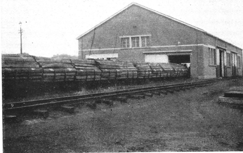
Stel creosoteerwagentjes rijdend van de kapmachines naar de persketels
