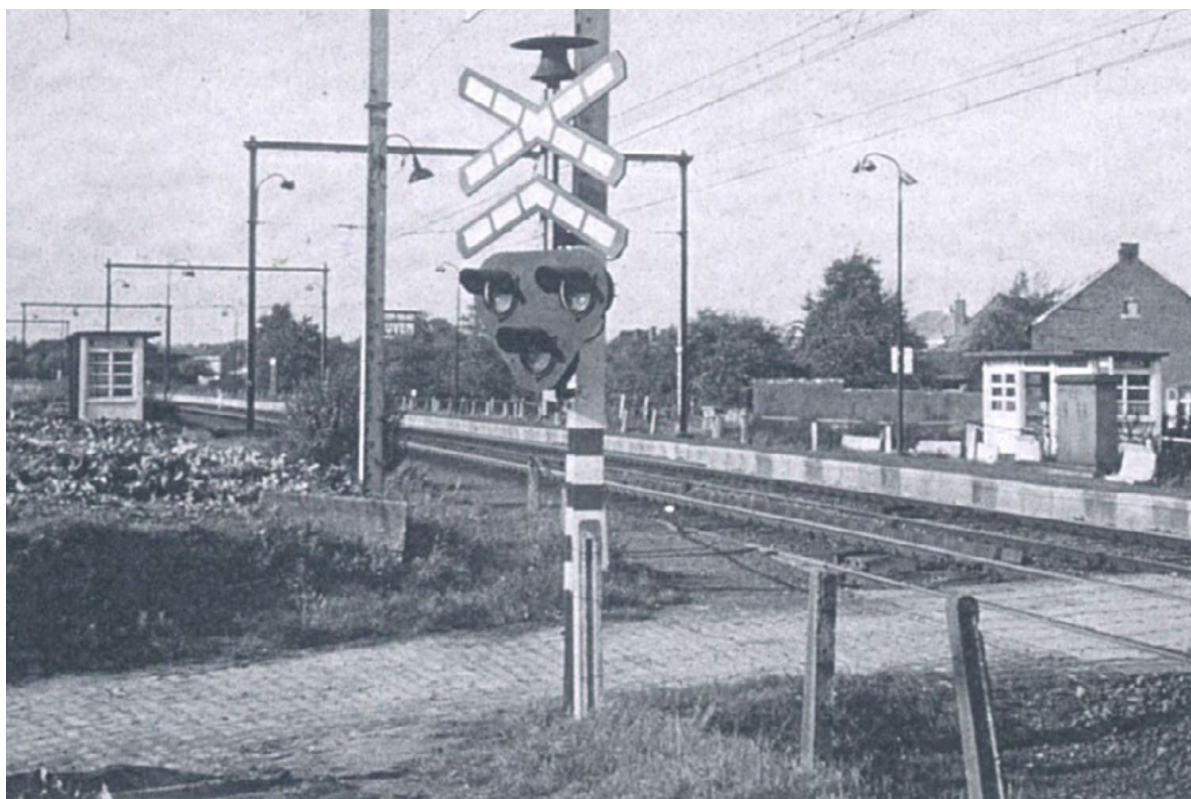
In de plaats van het stationsgebouw van Roosbeek, kwam er enkel een betonnen wachthuisje aan ieder spoor. Tot de treinstopplaats afgeschaft werd in 1984.
