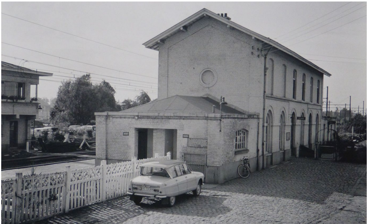
Het oude 'statiegebouw' vlak voor de afbraak
