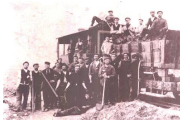
Grondwerkers bij een smalspoor waarmee het zand werd vervoerd. Foto: R. Wageman.
